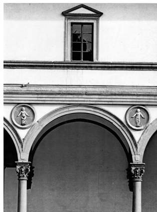
Tav. XLI: F. Brunelleschi, Ospedale degli Innocenti . Cornice di un arco del Portico (part.)
